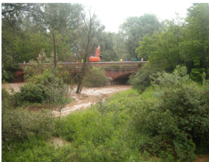
Ponte sul Mellea della vecchia strada statale (vista da valle) al momento della piena, con utilizzo di escavatore per asportare tronchi e ramaglie
