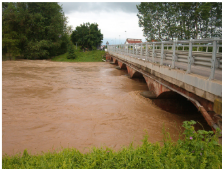
Condizione del ponte della Strada Provinciale per Monasterolo nel corso dell'evento di piena
