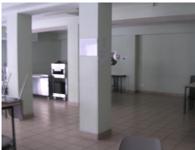
Travi ribassate nella mensa al piano seminterrato
